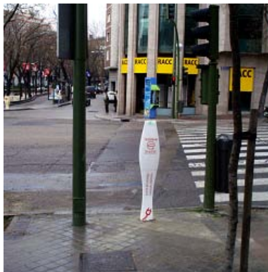
Primer poste de recarga de vehículos eléctricos en Madrid
